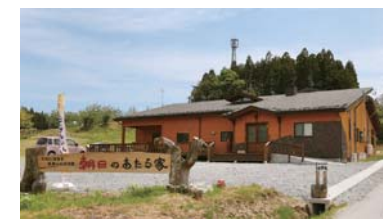
岩手県陸前高田市に開設した地域交流拠点「朝日のあたる家」
